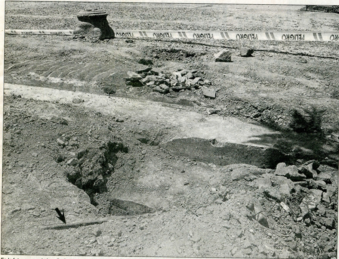
En la foto se aprecia la cañería de riego instalada por sobre los peldaños de la escalera original al construirse el parque. Todo fue después sepultado.
