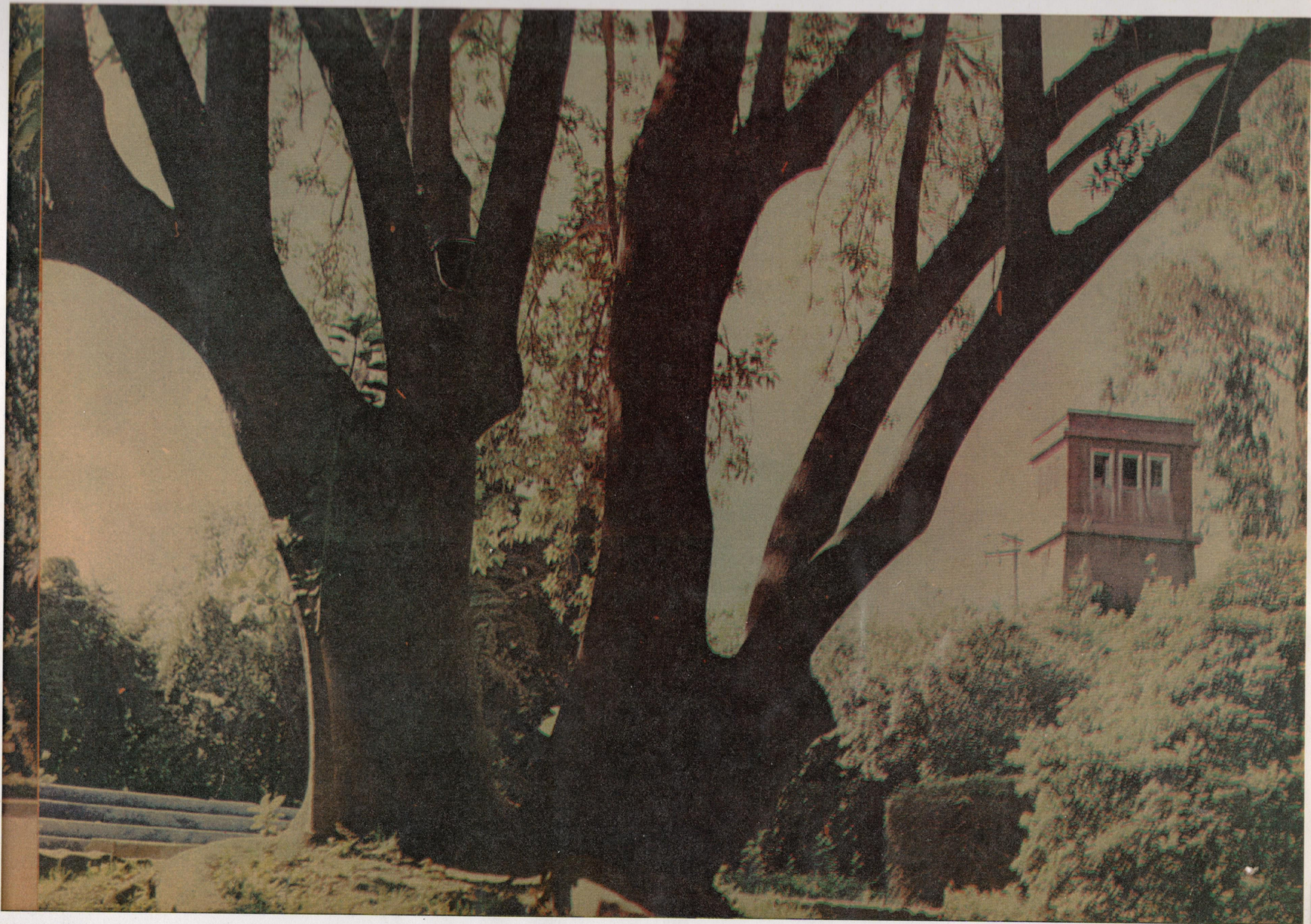
TORRE DE VILLA GRIMALDI (COSTADO SUR-PONIENTE)
